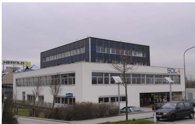
Vanjski izgled i dio unutrašnjosti zgrade SOL 4
